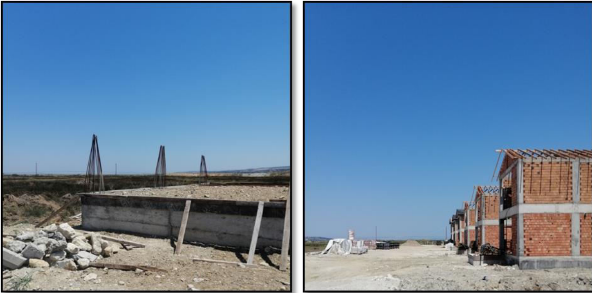
Şekil 10. Çalışma Alanı İnşaat Alanları
