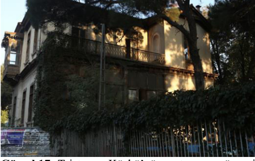
Görsel 17: Tristramp Köşkü'nün restorasyon öncesi durumu Kaynak: URL-8
