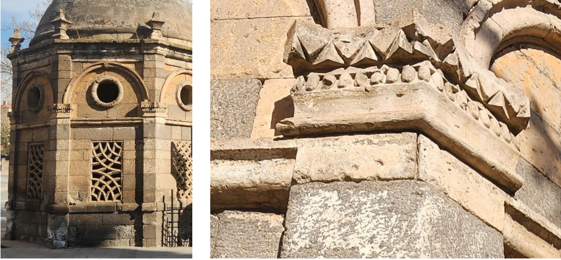
Görsel 7. Türbenin Köşe Sütunçeleri ve Başlık Detayı
