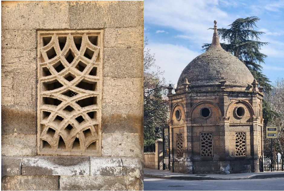
Görsel 6. Tübbenin Kuzey ve Kuzeybatı Cephelerindeki Pencere Şebekeleri
