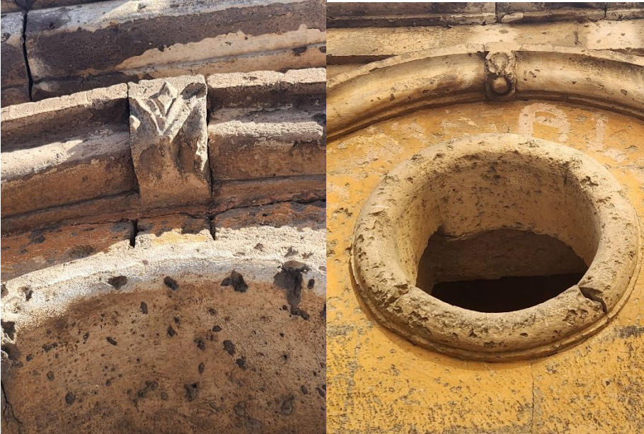
Görsel 8. Türbenin Yuvarlak Kemerlerinin Kilit Taşlarından Detay
