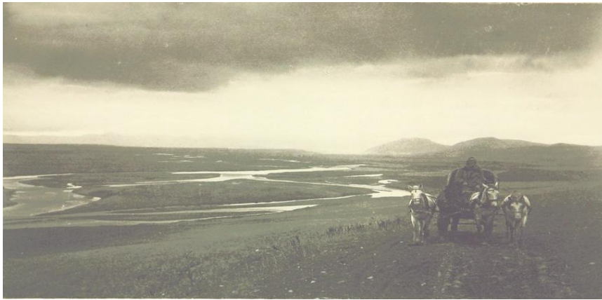
Resim-9: Warkworth'un Objektifinden 1897 Yılında Pasinler Ovası ve Aras Nehri 67
