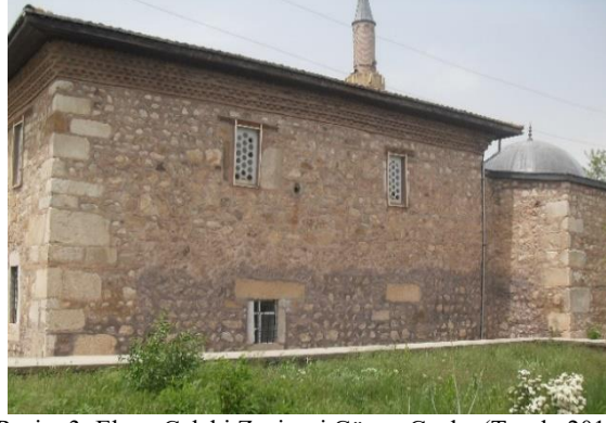
Resim 3: Elvan Çelebi Zaviyesi Güney Cephe (Toruk, 2010)
