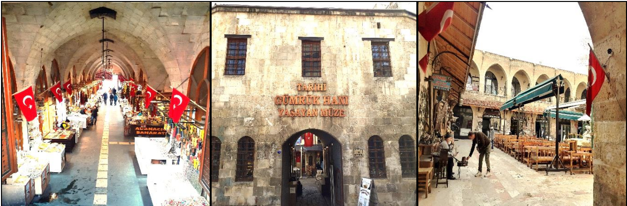
Fotoğraf 4- Geleneksel Kent Dokusunu Belirleyen Mimari Yapılar (Zincirli Bedesten-Gümrük Hanı-Millet Hanı) Photo 4- Architectural Buildings Determining the Traditional Urban Texture (Zincirli Bedesten-Customs Inn-Millet Inn)
